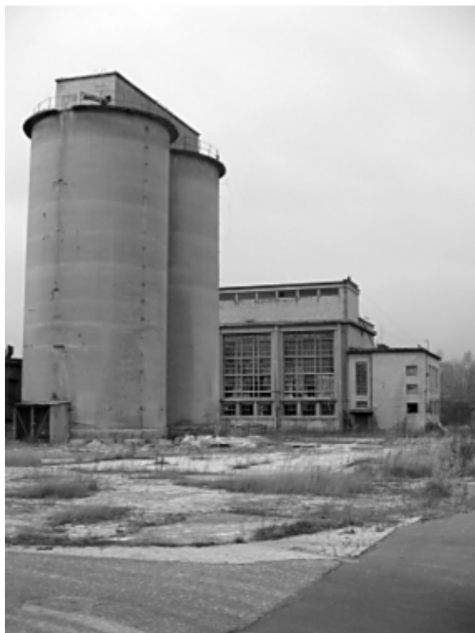
Zakład wyrobów cementowo-azbestowych w Szczucinie był jednym z największych zakładów tego rodzaju w Polsce.
