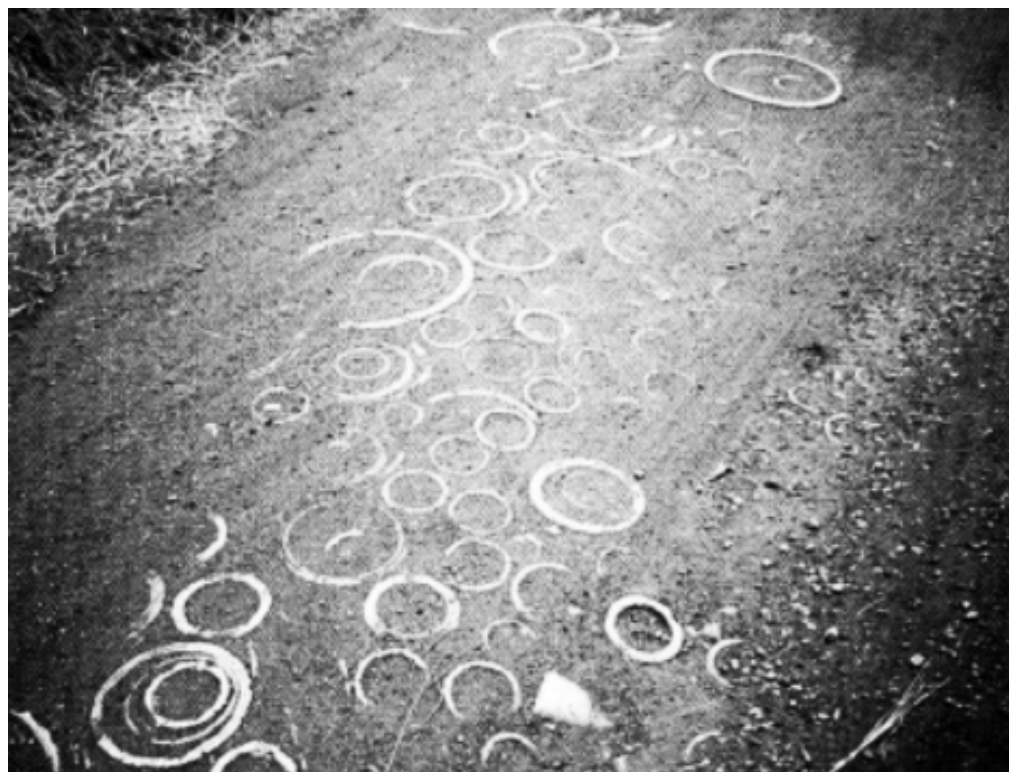
Do stabilizacji gruntu posłużyły tutaj końcówki rur cementowo-azbestowych.
