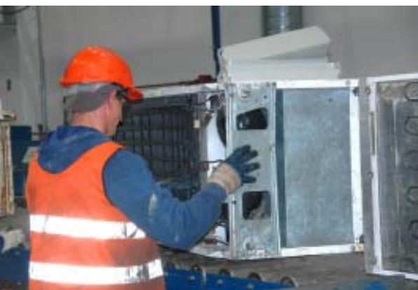
Szczególną chlubą zakładu jest linia do przetwarzania lodówek zawierających freon.
