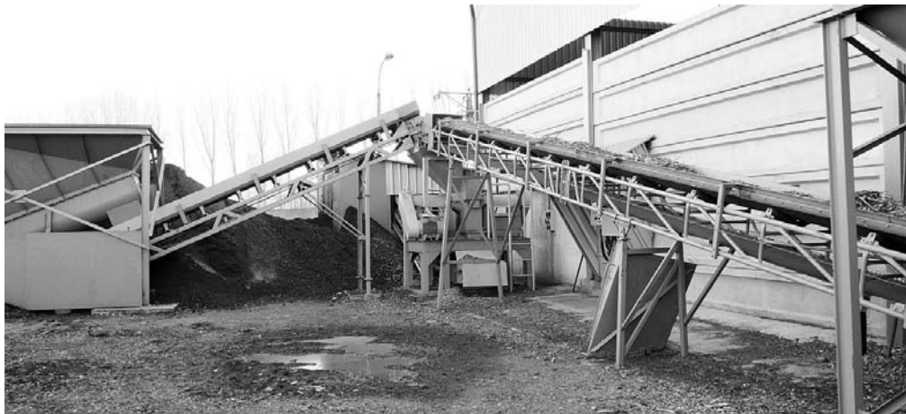
Dawny kocioł węglowy zasilany jest mieszanką pyłu węglowego i drobnych trocin. Na zdjęciu linia nawęglania kotła węglowego zestawiająca mieszankę do współspalania.
