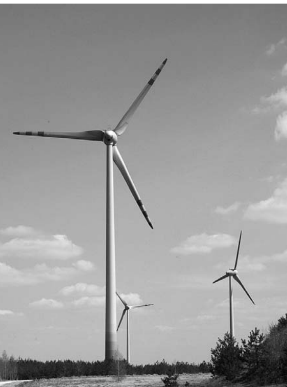
15 wiatraków i 30 MW mocy zainstalowanej na szczycie Góry Kamieńskiej.
