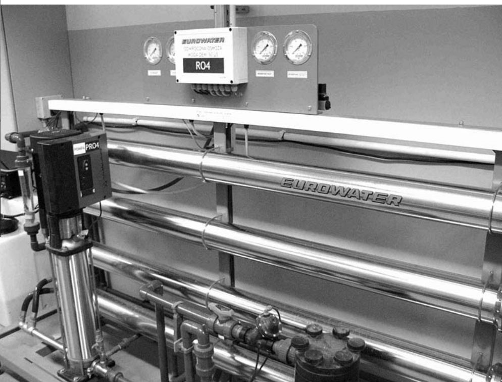
Odwrócona osmoza pozwala na oczyszczenie już niemal czystych ścieków z resztek zanieczyszczeń przed zawróceniem jej do procesu technologicznego.
