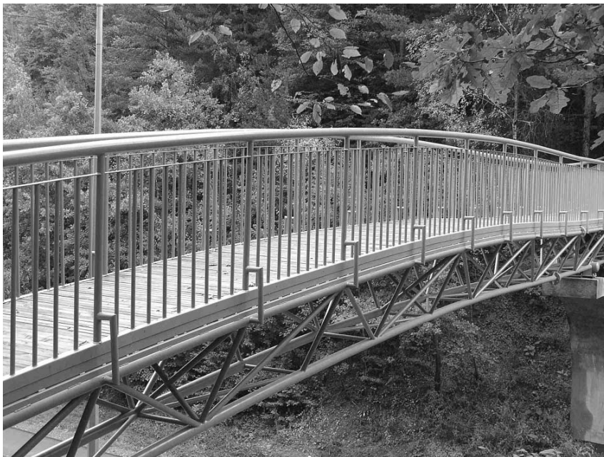
Aby zwiedzanie rezerwatu było bezpieczne zarówno dla zwiedzających, jak i dla przyrody, wykonano szereg prac, z których najważniejsza to budowa kładki nad bardzo ruchliwą i niebezpieczną drogą.
